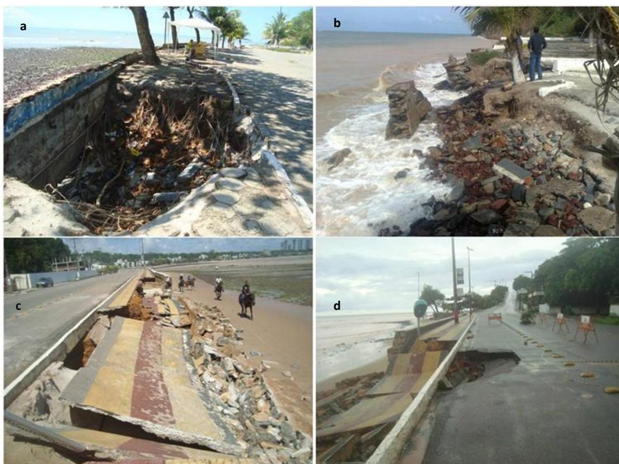
**Figura 5** Incidência da energia das ondas provocando destruição de patrimônio público (a e b) e o solapamento de construções e vias no entorno da Praça de Iemanjá (c e d).
