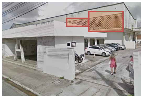
Figura 05: Cobogós do Clube Astréa na edificação e em imagem aproximada
