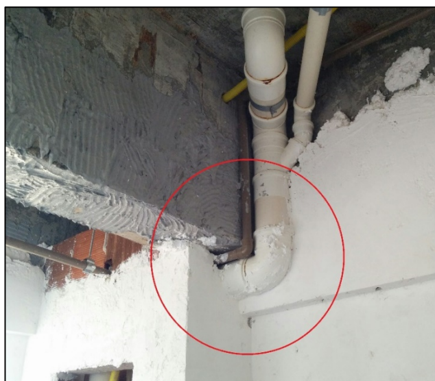
Figura 8 - Tubulação da bacia sanitária sendo passada por baixo da viga.
