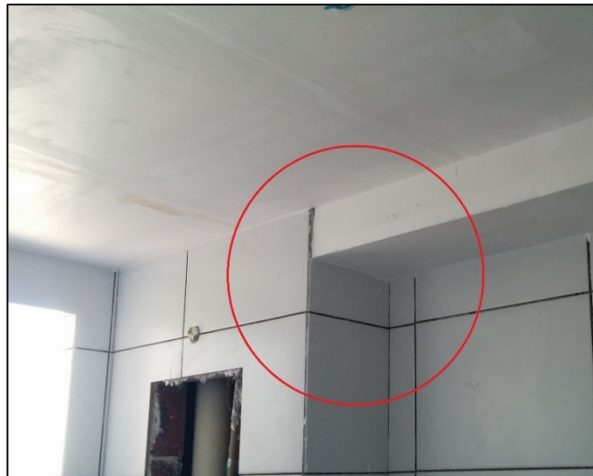
Figura 9 - Banheiro com o forro de gesso colocado.
