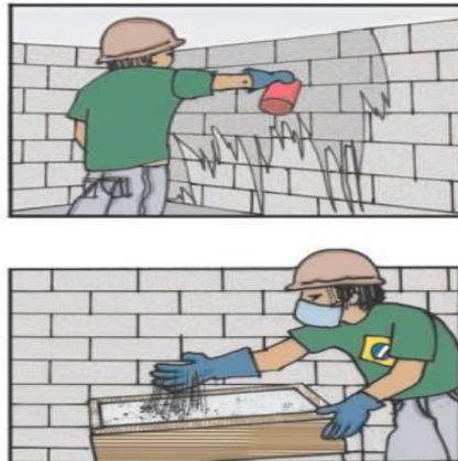
MOLHANDO A PAREDE E POLVILHANDO O GESSO PARA FAZER A MISTURA
