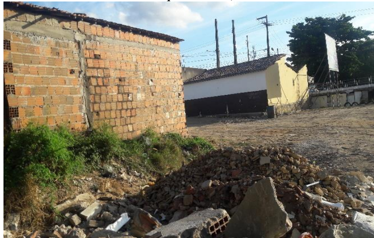
Figura 16 - Resíduos da construção civil depositados indevidamente na APP (Dados da Pesquisa, 2018).
