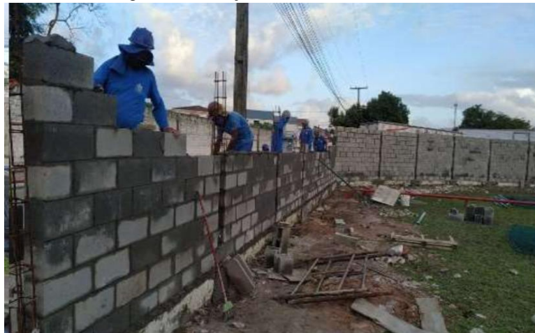
Figura 7: Execução de alvenaria estrutural em trecho
