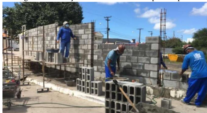
Figura 5: Execução de alvenaria externa pela empresa C
