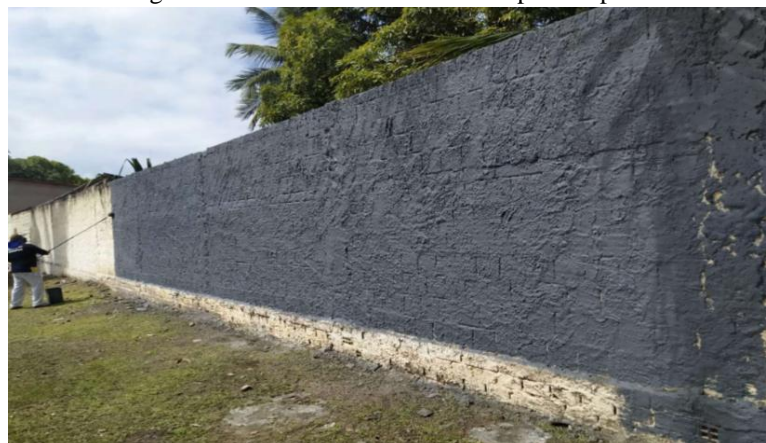
Figura 2: Pintura de muros externos pela empresa A
