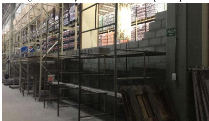
Figura 6: Execução de alvenaria interna pela empresa C
