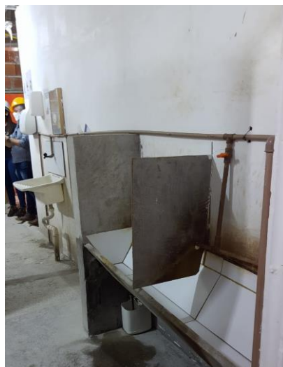
Figura 8 – Mictório dos trabalhadores Fonte: Arquivo pessoal dos autores
