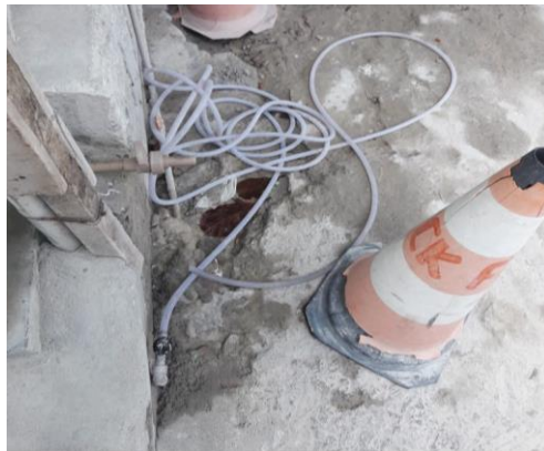
Figura 4 – Torneira e mangueira sem redutores de vazão
