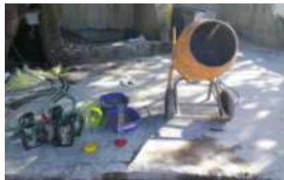
Figura 7 – Posicionamento de material dosado
