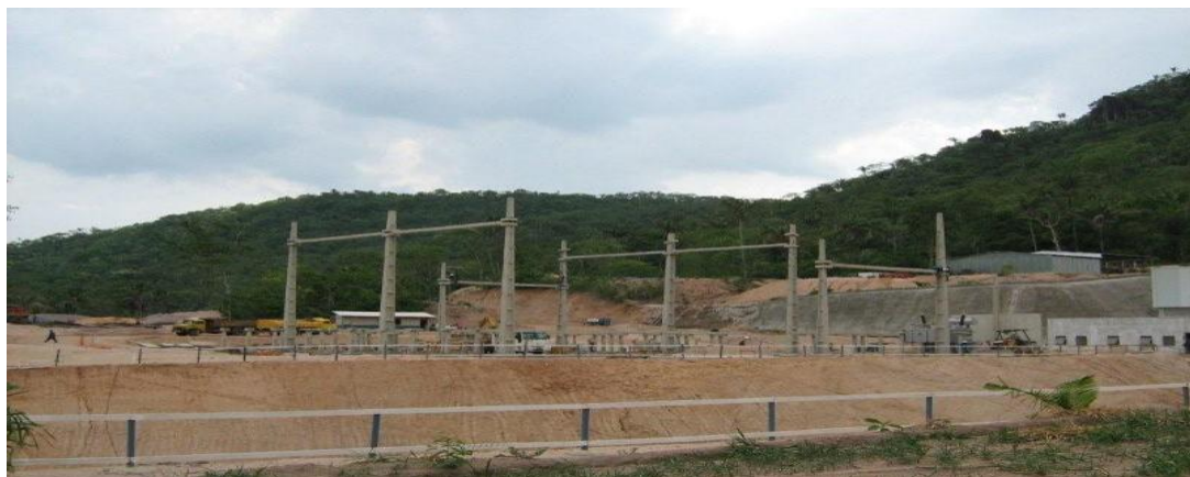
Figura 8 Início de construção de uma Subestação com 25 mva/138kv e tomada d'água PCH em São Thadeu. Santo Antonio Leverger–MT.
